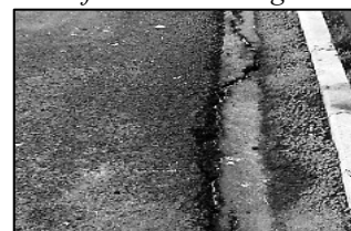
i. Edge cracking
