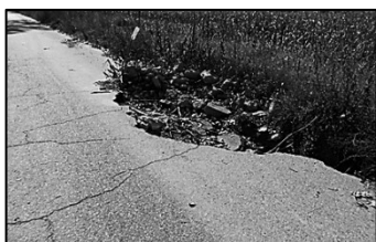
j. Edge failure
