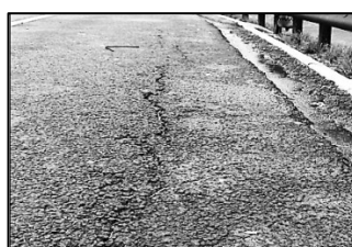
b. Longitudinal crack
