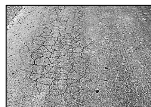
l. Fatigue cracking
